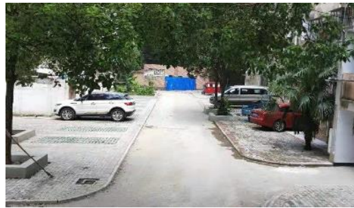
銅陵分行 - 銅陵市老舊小區改造項目改造後
